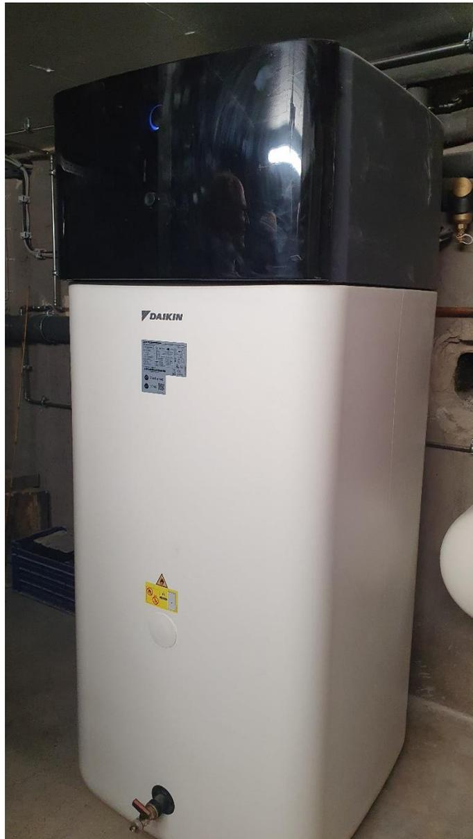
Die Wärmepumpe und der Speicher für warmes Wasser
