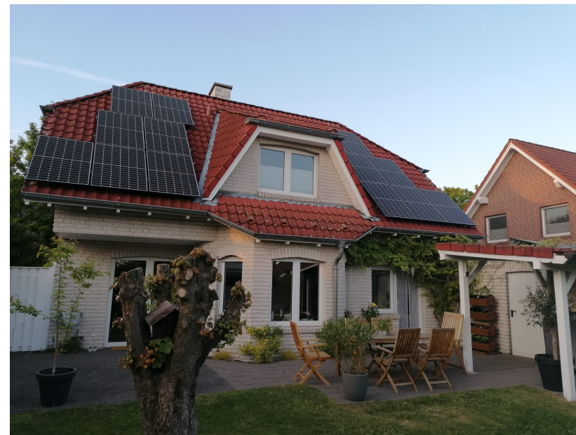
Dach mit Ausbauten, Flachdächer, Carports etc.
